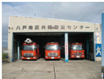
防災センター
